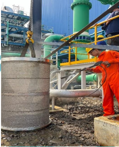
Gambar 3 : Cuci Strainer yang kotor
