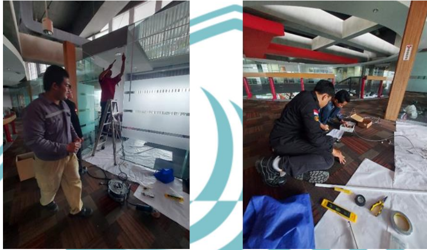
Instalasi Fingerprint dan Smart Lock Door
