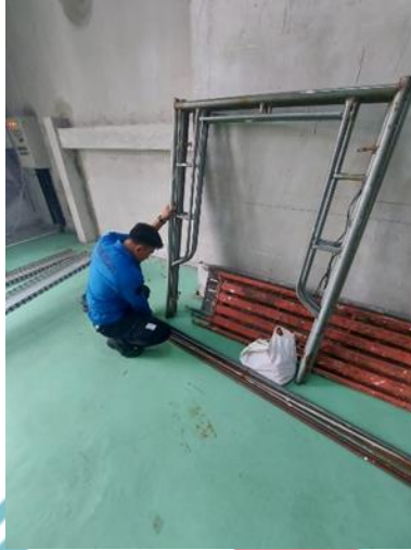
Instalasi Scaffolding pada Lantai 2
