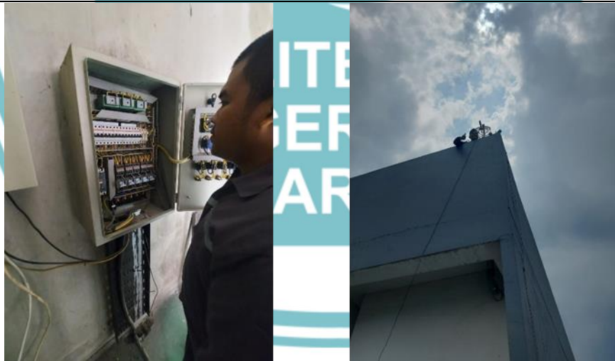
Instalasi CCTV Pada Gedung Tempo
