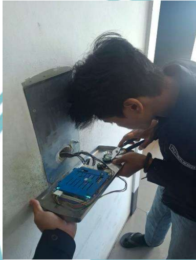
Perbaikan tombol lift lantai 2
