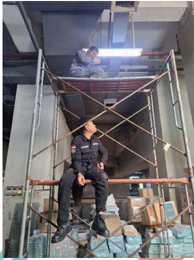
Instalasi Scaffolding dan pergantian lampu pada area produksi
