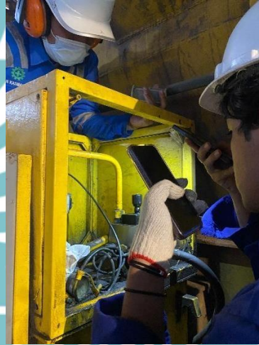
Gambar 33 Perbaikan pompa tension SSC 3
