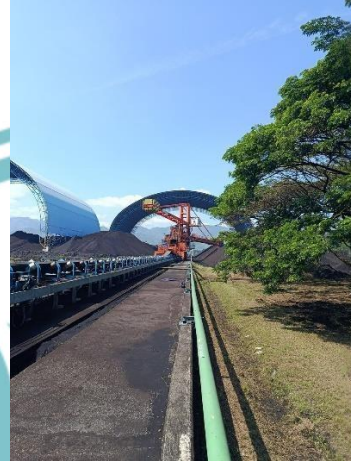
Gambar 25 STRE di coal yard
