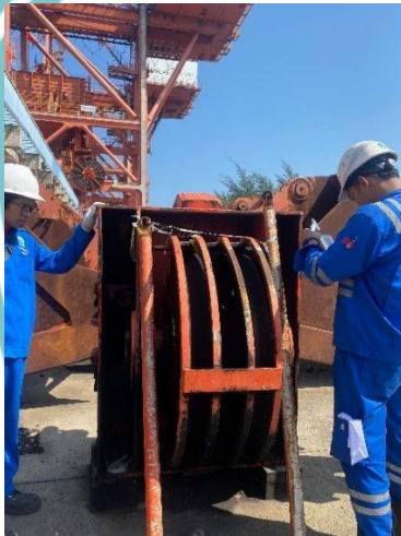
Gambar 26 Mempersiapkan komponen pim arm spare grab SU
