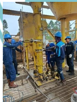
Gambar 15 Penggantian Valve FAS Baru
