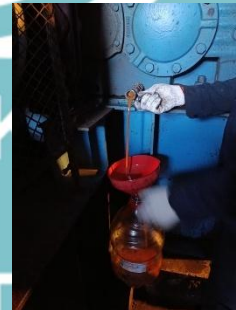
Gambar 6 Penggantian Oli Gearbox BC 3
