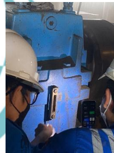
Gambar 4 Pengecekan Level Oli
