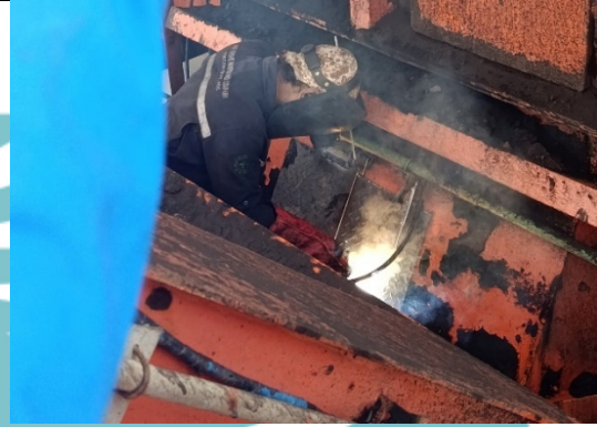
Gambar 5.16 Pengelasan Manholl Chute SU
