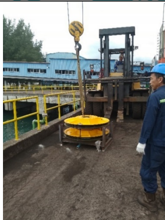
Gambar 5.5 Penggantian Pulley SU 1
