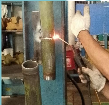
Gambar 2 Pembuatan Alur Pipa Kompresor Baru
