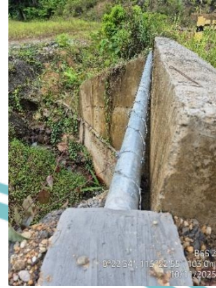
Gambar 3.16. Pembuatan BSS area crossing sungai kecil
