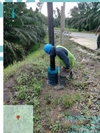
Gambar 3.14. Pemasangan Tiang Kabel Udara
