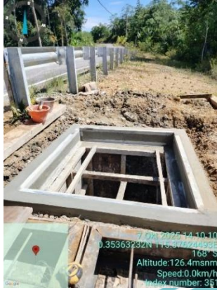
Gambar 3.15. Pembuatan Handhole dengan spesifikasi HH-MH2 pada design pack
