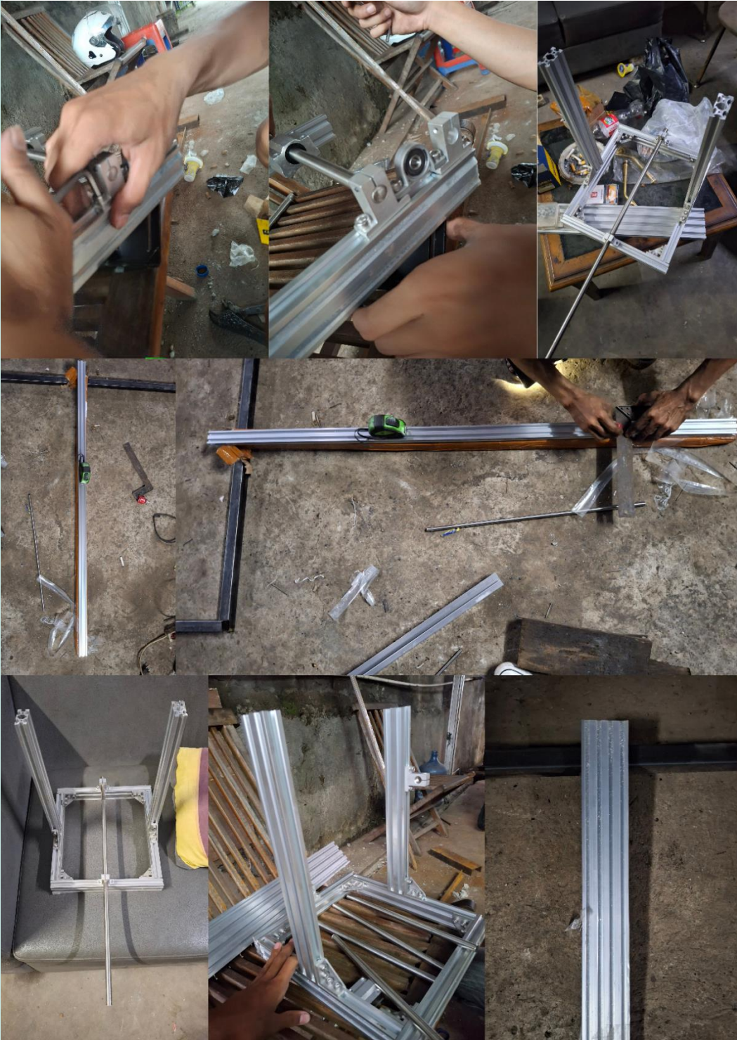
Lampiran 11. Dokumentasi Proses Pabrikasi Frame Dalam
