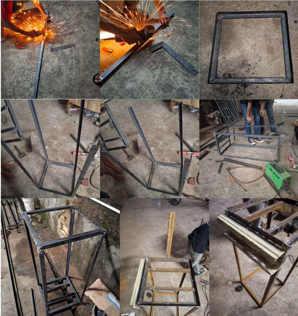
Lampiran 10. Dokumentasi Proses Pabrikasi Frame Luar
