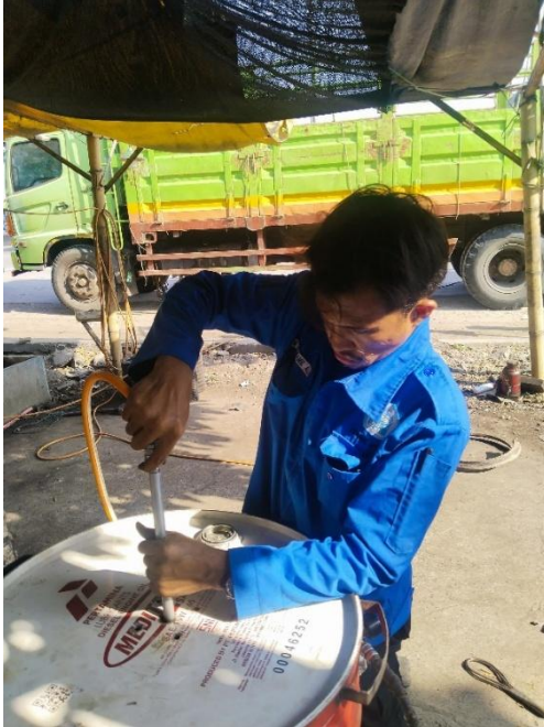
Memasang coupler angin dari selang ke pipa nozzle
