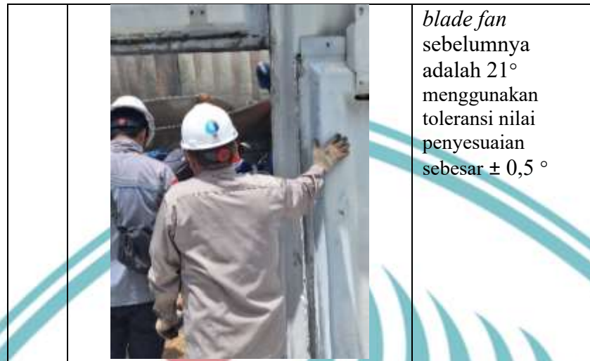
Lampiran 3. Hasil penyesuaian kemiringan sudut blade fan cooling tower dengan nilai toleransi \pm 0,5^\circ
