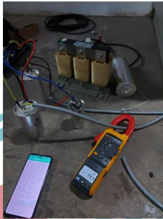
Pemasangan filter pasif LC untuk individual harmonik arus orde 5 pada panel distribusi inverter motor chiller
