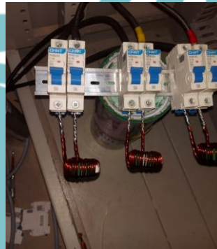
Pemasangan filter pasif LC untuk individual harmonik arus orde 5 pada panel distribusi inverter motor chiller
