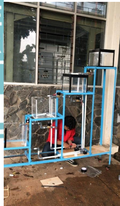
Lampiran 3 Pemasangan Pipa
