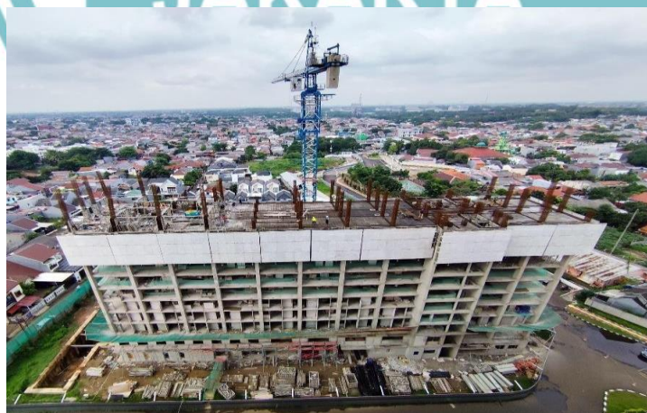
Gambar 1. 1 Gedung Tower B Proyek Nuansa Cilangkap (Sumber : Dokumentasi Proyek)
