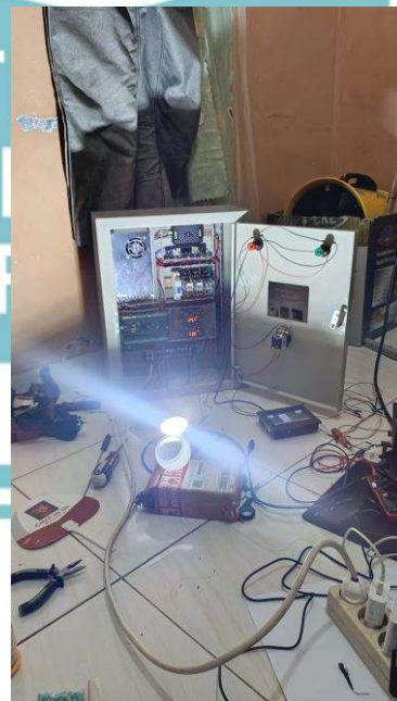
Proses pengujian pembacaan sensor PZEM-017 dengan beban lampu DC
