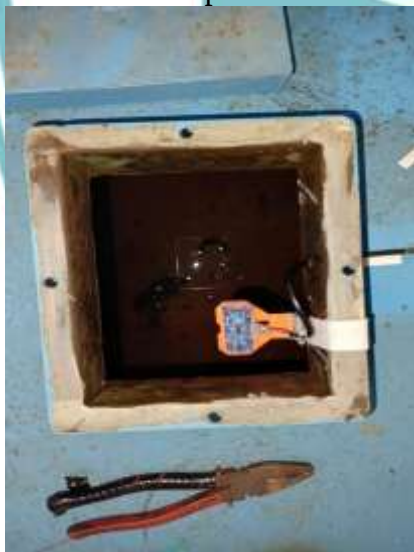
Dokumentasi penempatan sensor ultrasonic pada tangki
