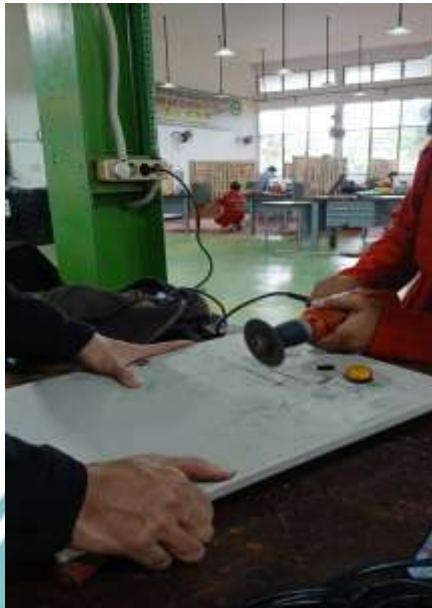
Dokumentasi pada saat menggerinda box panel
