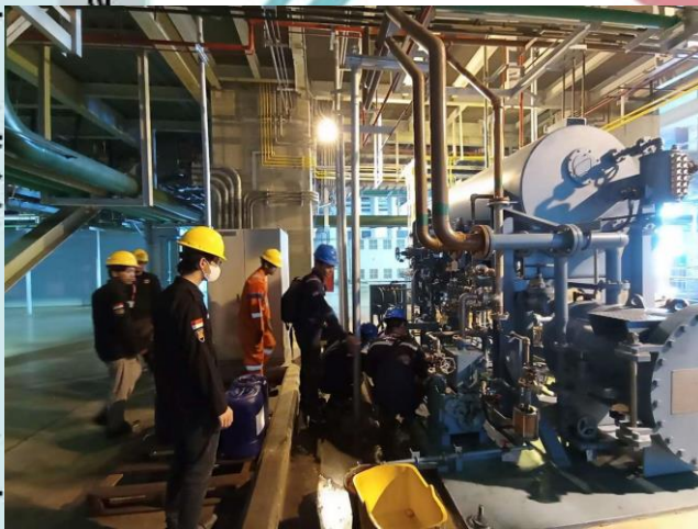
Lampiran B. 6 Pengambilan Data Vibrasi pada Condenser Vacuum Pump
