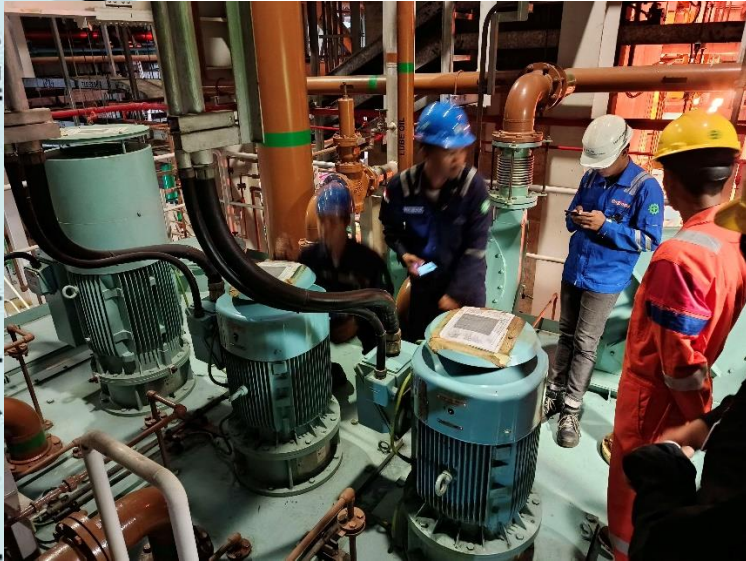
Lampiran B. 5 Pengambilan Data Vibrasi pada Seal Oil Supply dan Motor Pompa
