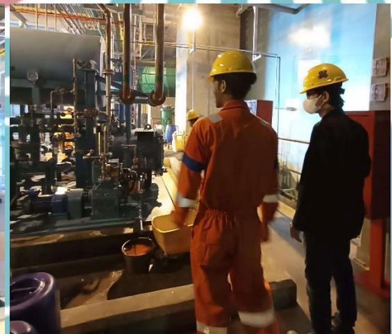
Lampiran B. 6 Pengambilan Data Vibrasi pada Condenser Vacuum Pump
