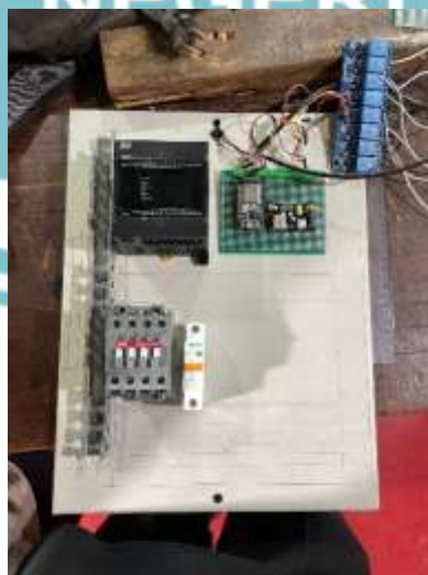
Gambar 3. 15 Pemasangan Layout Komponen
