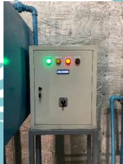
Gambar 3. 11 Realisasi Kerangka Pintu Panel
