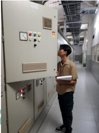
Lampiran 4 Loogsheet Pompa Chiller
