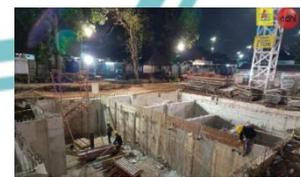
Gambar 4. 33 Pembongkaran Bekisting Dinding
