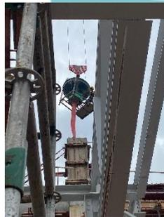
Gambar 4. 30 Pengecoran pada kolom
