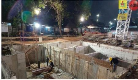
*Gambar 4. 19 Pembongkaran Bekisting Dinding*
