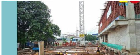
*Gambar 4. 21 Pemasangan Bekisting Plat*
