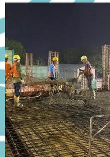
Gambar 4. 31 Pengecoran pada Pelat lantai
