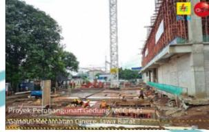
Gambar 4. 28 Pemasangan Bekisting Pelat Lantai
