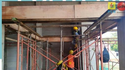
*Gambar 4. 22 Pemasangan Bekisting Balok*
