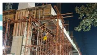
Gambar 4. 34 Pembongkaran bekisting Balok
