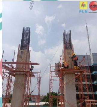
*Gambar 4. 20 Pembongkaran Bekisting Kolom*
