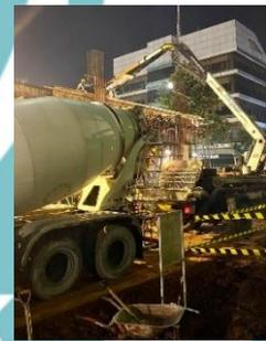
Gambar 4. 29 Pengecoran pada Balok
