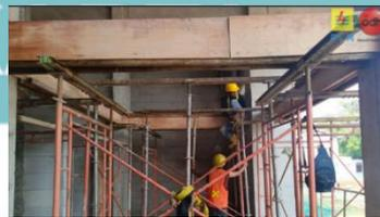
Gambar 4. 27 Pemasangan Bekisting Balok
