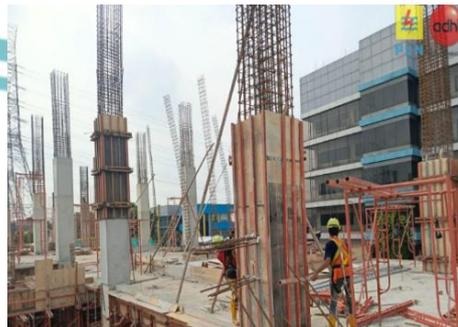
Gambar 4. 18 Pemasangan Bekisting Kolom
