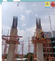
Gambar 4. 32 Pembongkaran bekisting kolom
