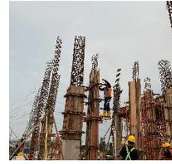
Gambar 4. 26 Pemasangan Bekisting Kolom
