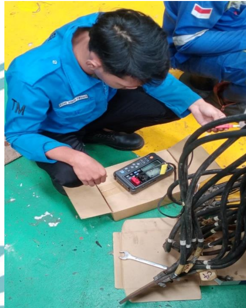
Proses RDC test pada stator generator
