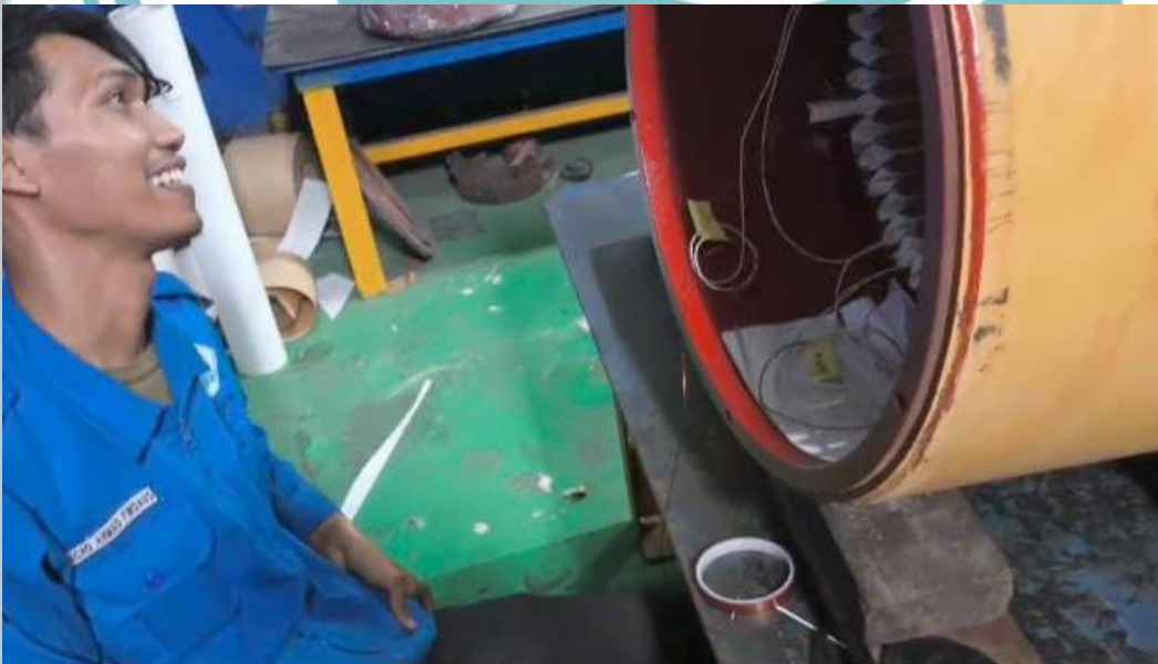
Proses penggulangan kabel auxiliary pada stator generator
