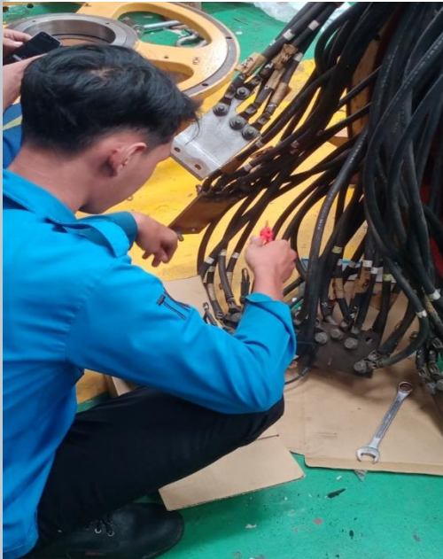
Proses RDC test pada stator generator
