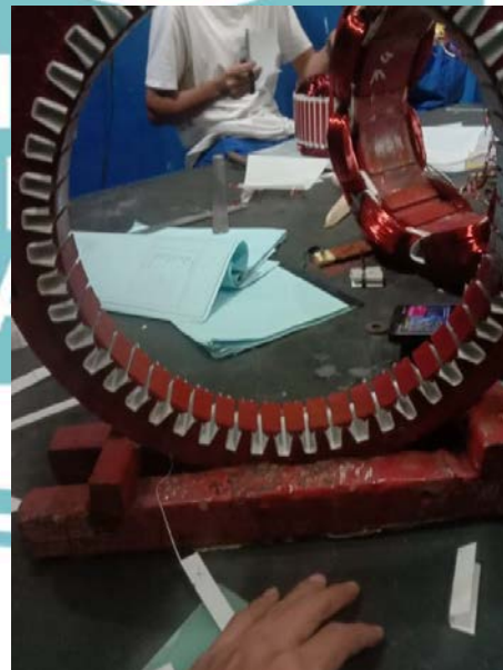
Proses pemasangan nomex pada exciter
