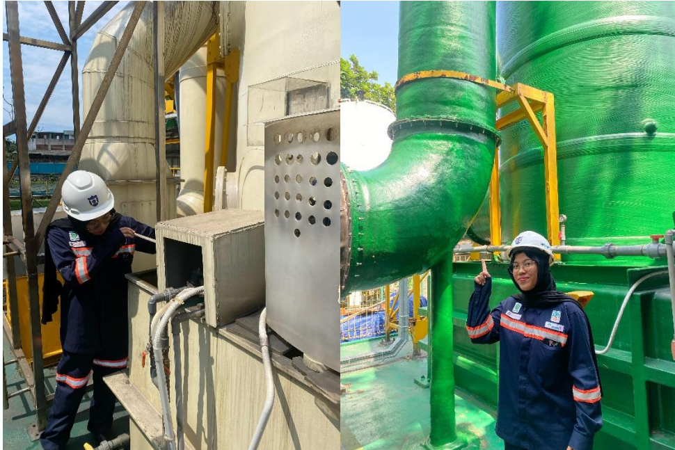
lampiran 12 pengecekan air pada tangki sirkulasi dan visual check pada wet scrubber
