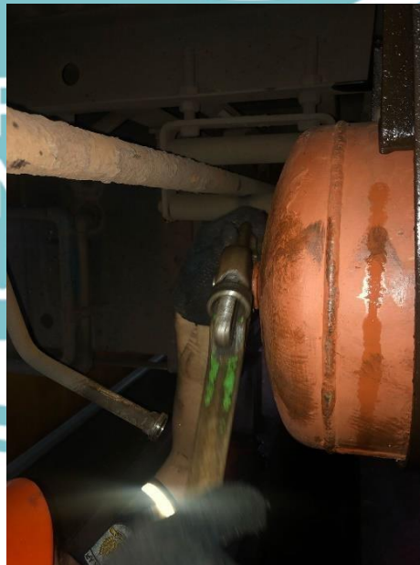
(Pemasangan regulator tangki AR untuk menghubungkan pipa angin dan tangki AR)
