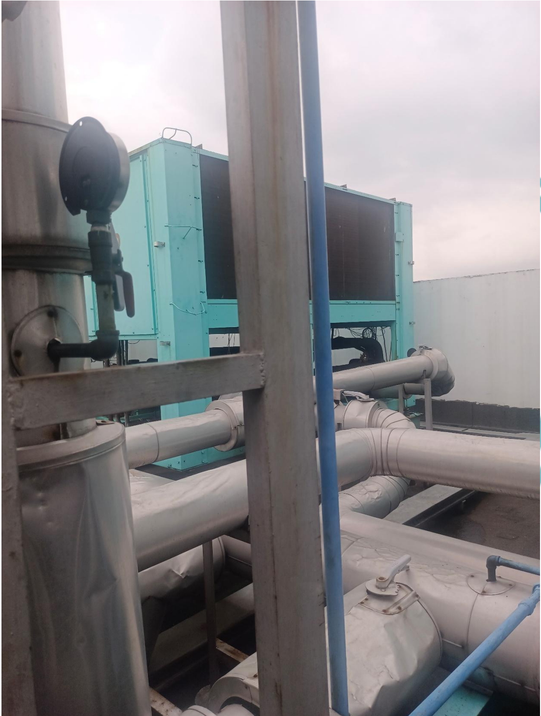
Lampiran 3. Dokumentasi On site training untuk desain jalur pipa AHU dan penempatan cooling tower
