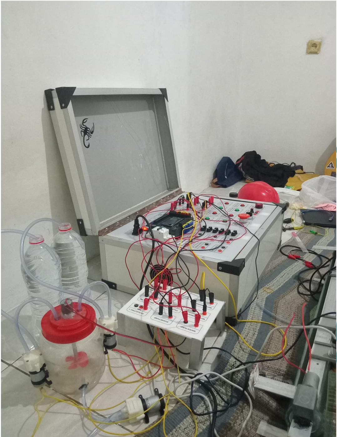
Modul Sensor dan Aktuator dengan Plant Mixing dan Filling
