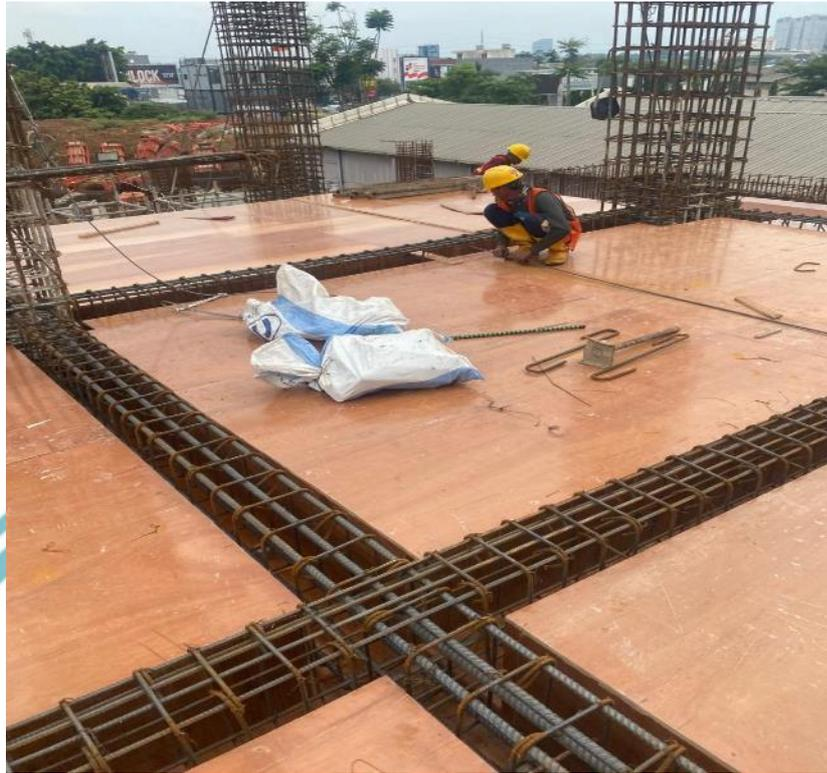
Gambar 4.37 Pemasangan Bekisting Pelat Lantai dan Balok
