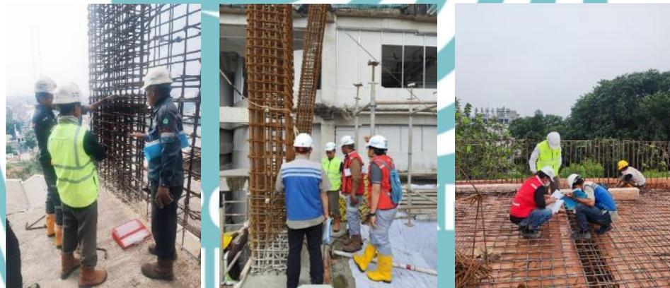
Gambar 4.15 Dokumentasi *Checklist* pembesian Plat Lantai, Balok, Kolom, dan Shearwall.
