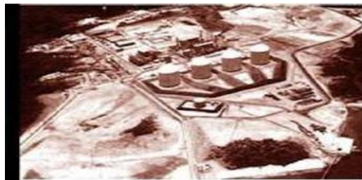
Gambar 2. 1 Kondisi 2 Train Kilang Badak LNG
