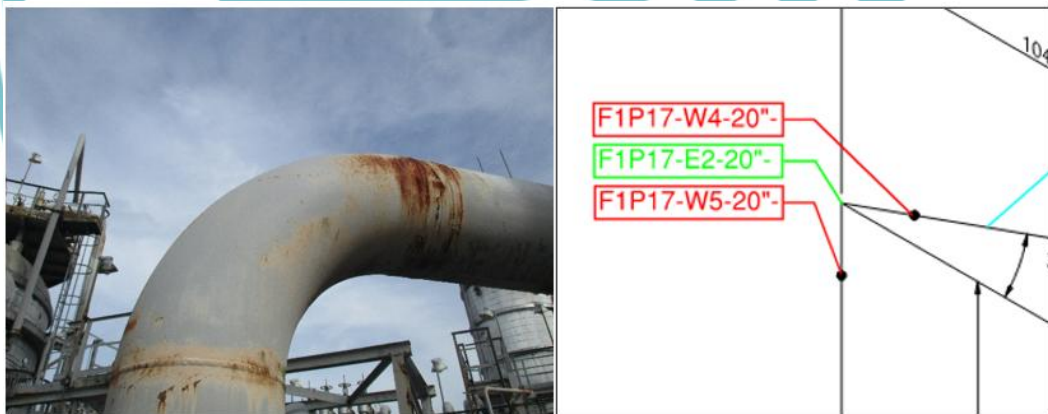
Lampiran 2.3 Kondisi Korosi Pipa F1P17-20-FG2D
