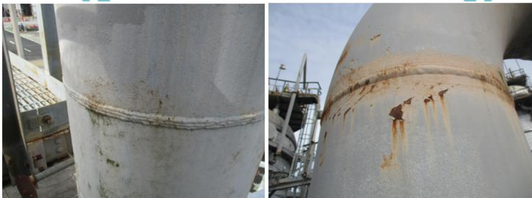
Lampiran 2.3 Kondisi Korosi Pipa F1P17-20-FG2D
