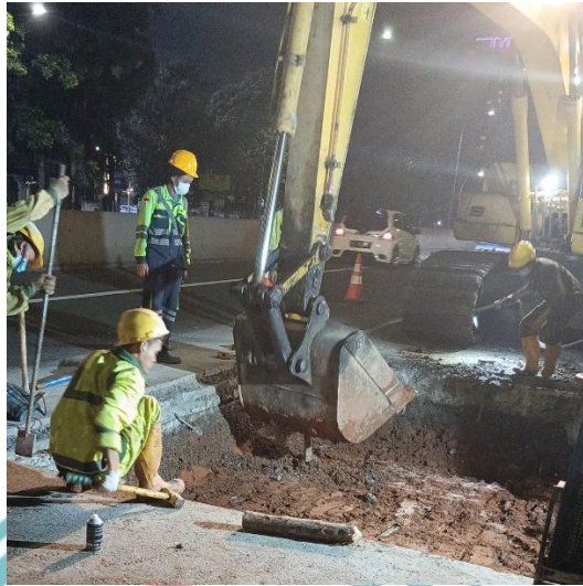
Gambar 3. 44 Pemasangan Cerucuk Menggunakan Excavator
