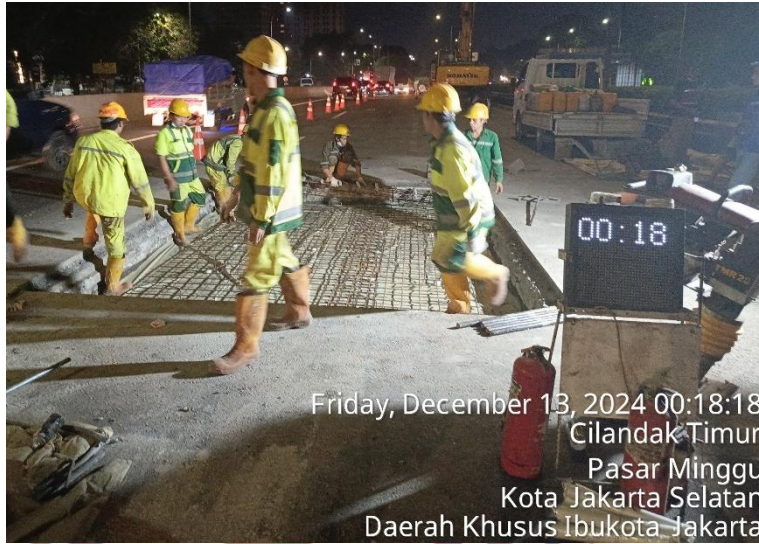
Gambar 3. 56 Instalasi Rebar Bagian Bawah
