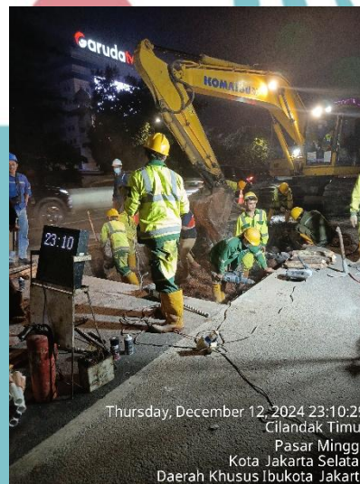
Gambar 3. 41 Pembongkaran Perkerasan Eksisting dengan Jack Hammer dan Excavator
