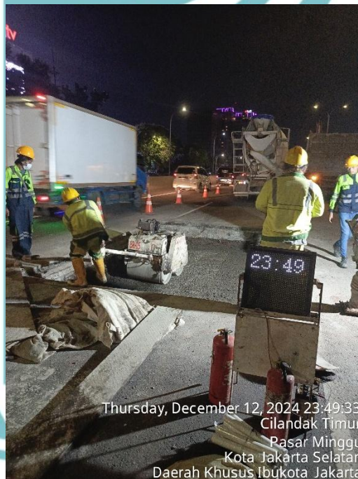
Gambar 3. 52 Pematatan Lapisan Subgrade dengan Baby Roller
