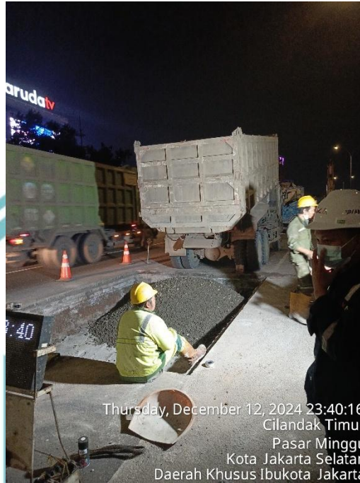
Gambar 3. 49 Unloading Agregat Tipe A dari Dump Truck
