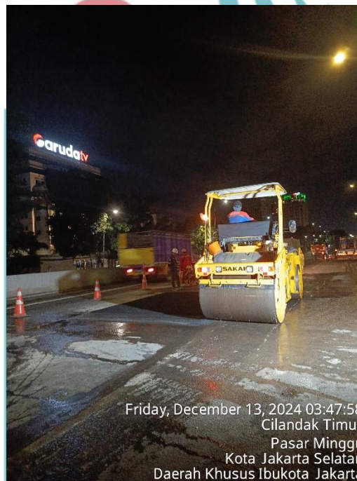
Gambar 3. 69 Pemadatan Aspal dengan Tandem Roller
