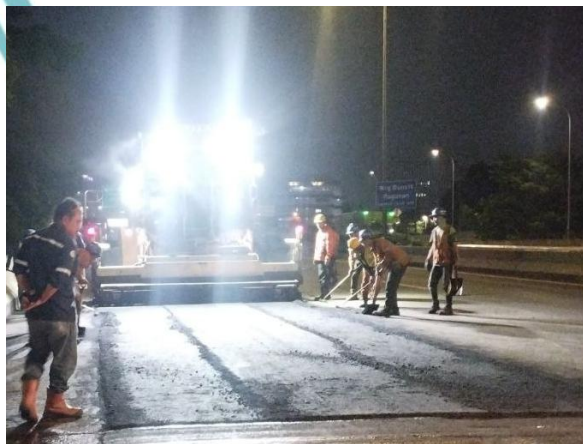
Gambar 3. 68 Filling Aspal dengan Asphalt Finisher
