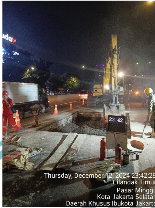
Gambar 3. 50 Proses Spreading Aggregate Menggunakan Excavator
