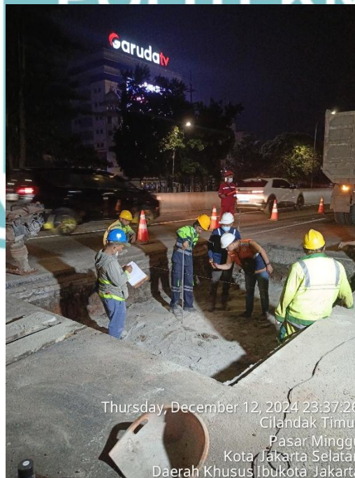
Gambar 3. 48 Quality Control Ketinggian Lapisan Tanah Dasar Eksisting
