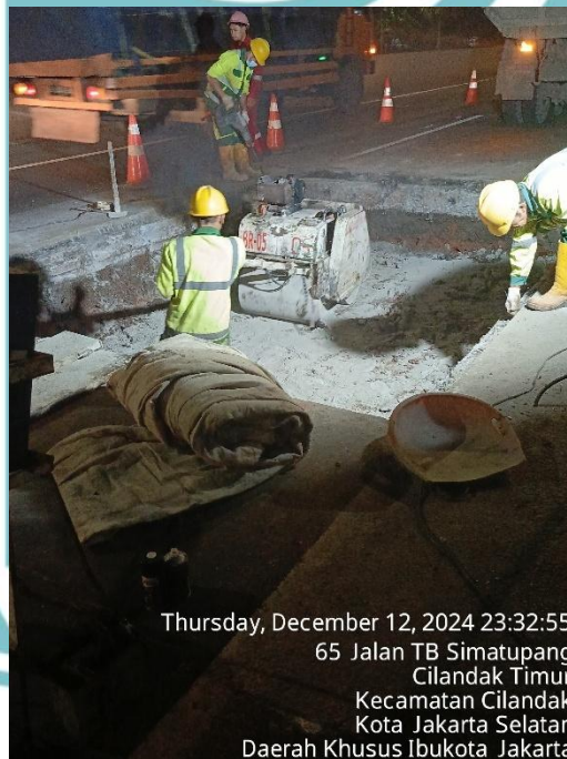
Gambar 3. 47 Pemasangan Lanjutan Lapisan Tanah Dasar Eksisting dengan Baby Roller
