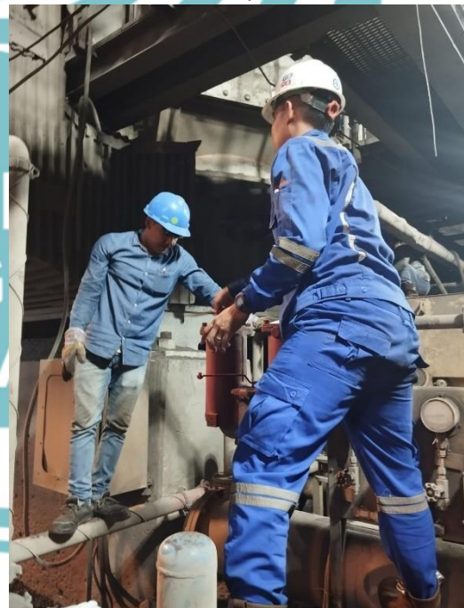
Penggantian Filter Oli Lube Station MSM 2C
