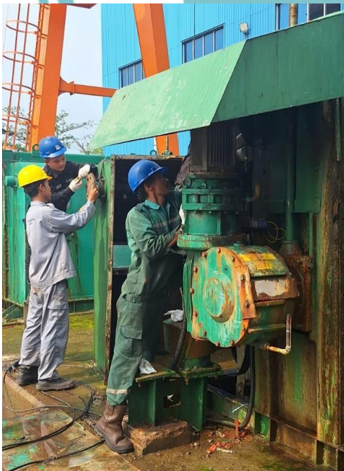
Pemasangan Cover TBS 2B
