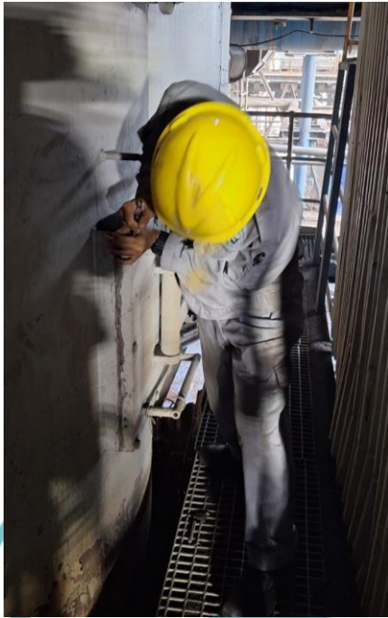
Open Manhole MSM 2A
