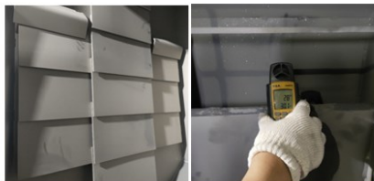
kecepatan hisap masih kurang menghasilkan banyak debu pada liner
