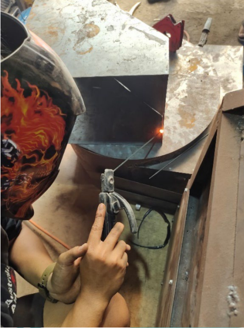
Lampiran 4 Dokumentasi Pengerjaan Panel Box
