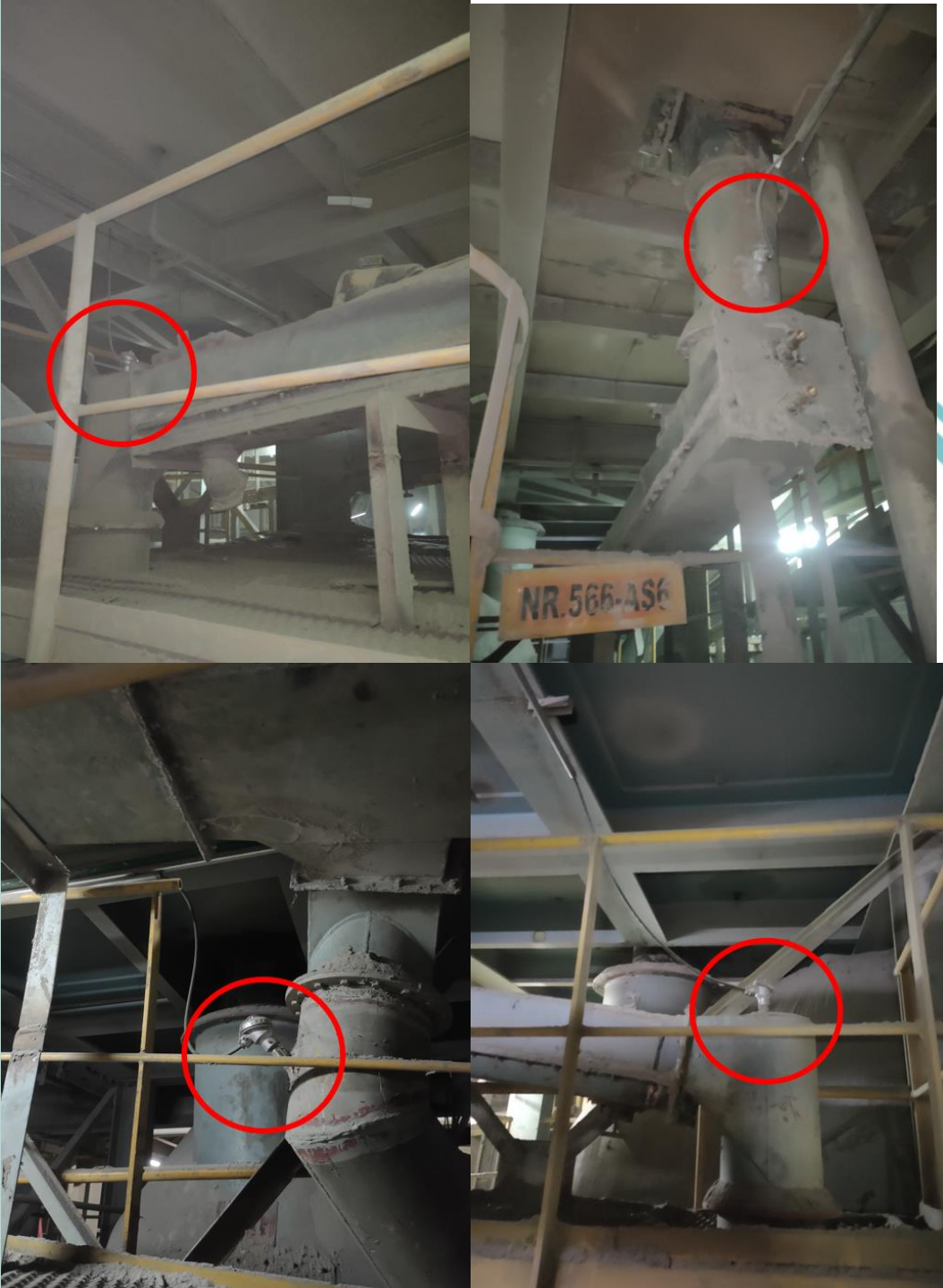
Lampiran 7. Hasil pemasangan sensor RTD di airslide
