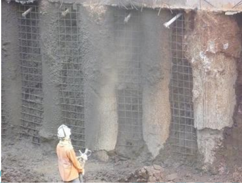
Lampiran 5. Dokumentasi Pekerjaan Shotcrete
