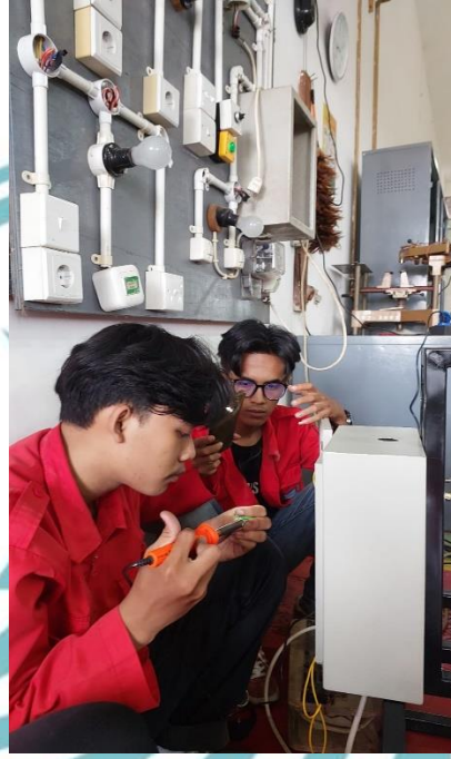
proses penyolderan komponen panel
