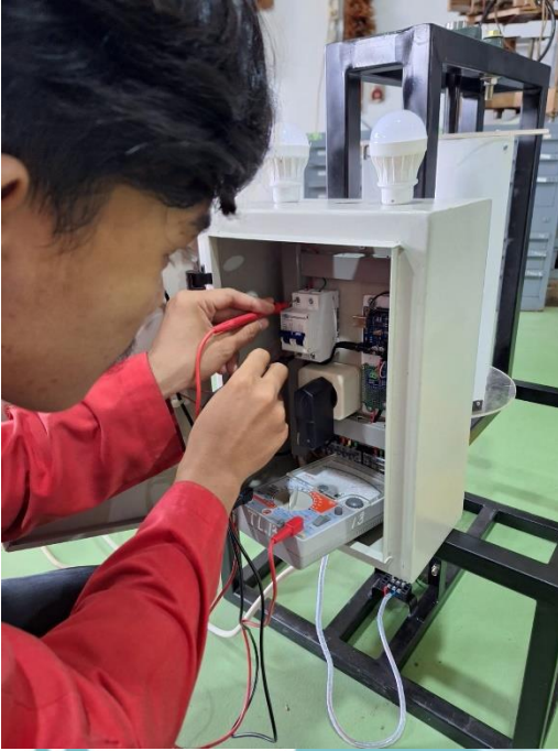
Proses pengujian kontinuitas
