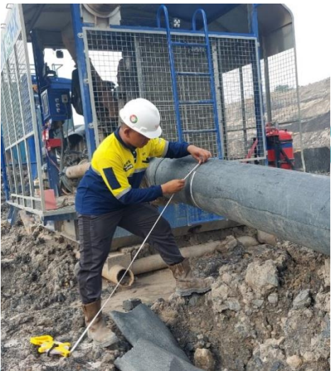
Pemasangan pipa HDPE
