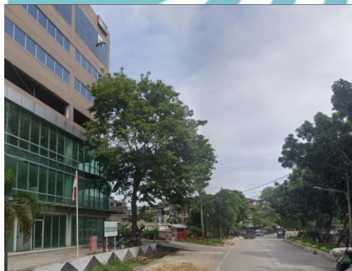
Lampiran 1 9 Kondisi Jl. Jembatan Merah
