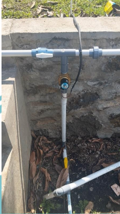
L6 Pemasangan solenoid valve
