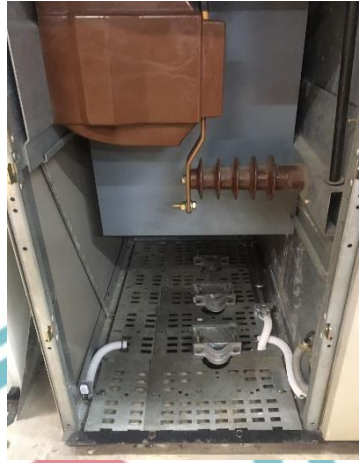
Proses Pengerjaan dan Pemasangan Sensor DHT 22
