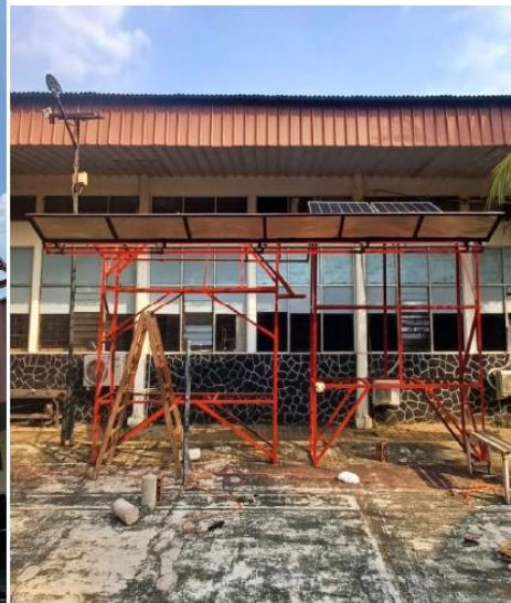
PROSES PEMASANGAN REFLEKTOR
