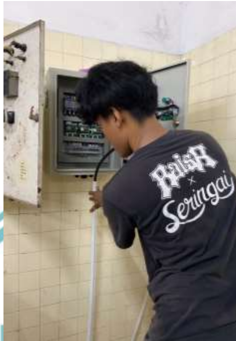
Lampiran 1. 7 Pemasangan Kabel Sumber
