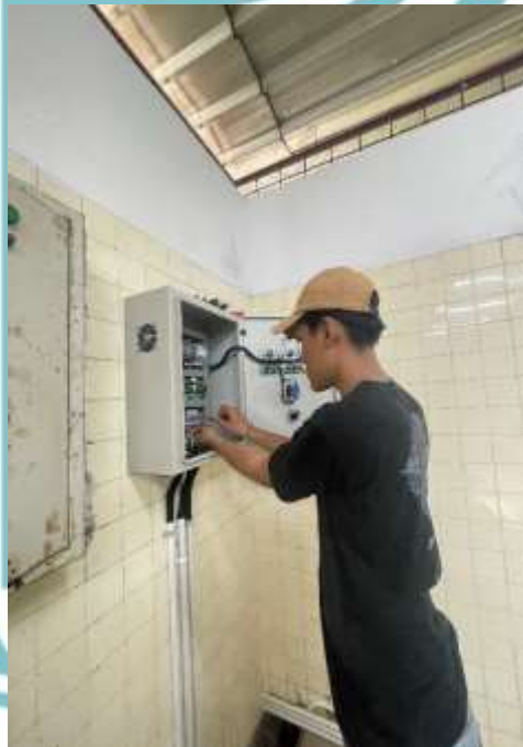
Lampiran 1. 8 Pemasangan Kabel Sensor
