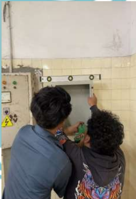
Lampiran 1. 6 Pemasangan Panel Box
