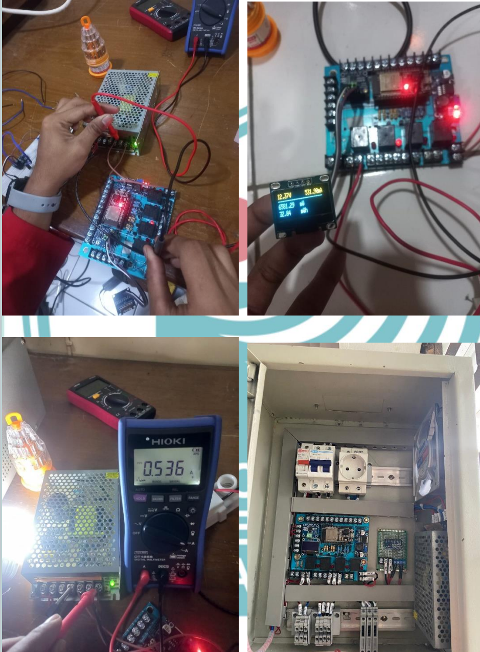
Proses Kalibrasi Sensor dan Pemasangan Komponen Panel Kontrol
