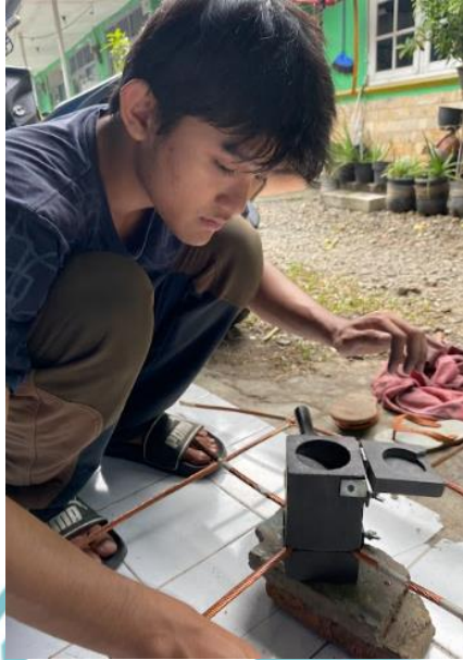
Pembuatan Grounding Grid
