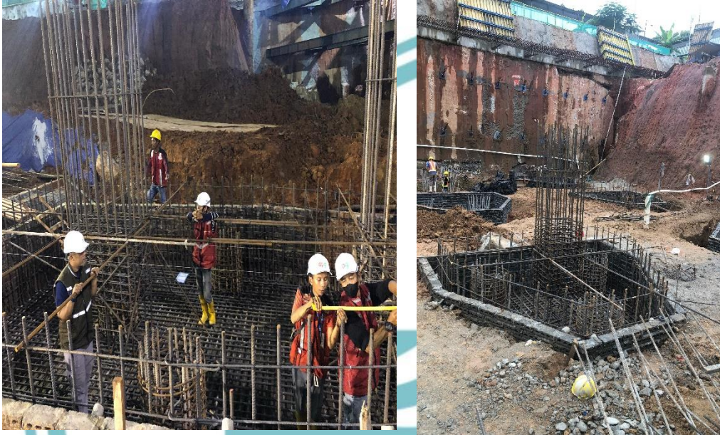
Gambar 4.2: Pondasi Pilecap
