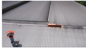
Gambar 4.30 Kesalahan dalam pendeteksian. Pada Gambar 4.27 terdapat kesalahan dalam mendeteksi karat, namun pada gambar tersebut mendeteksi noda dengan nilai kepercayaan 0.26.
