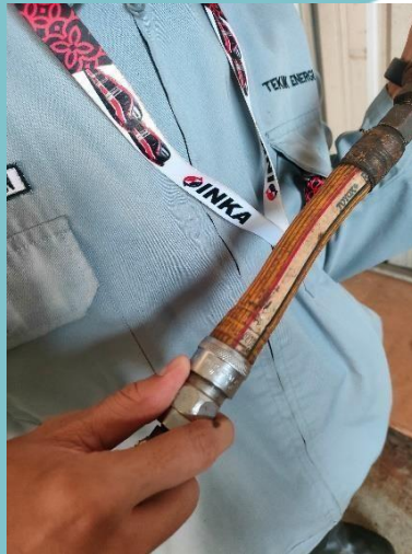
Gambar 3.18 Setelah di kencangkan dengan tali kompresor
