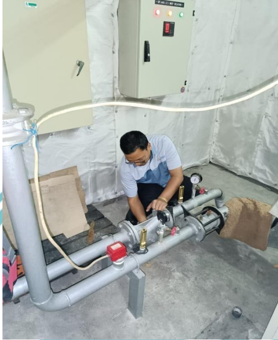
Lampiran 1. Pembersihan Strainer Valve Pada WCP
