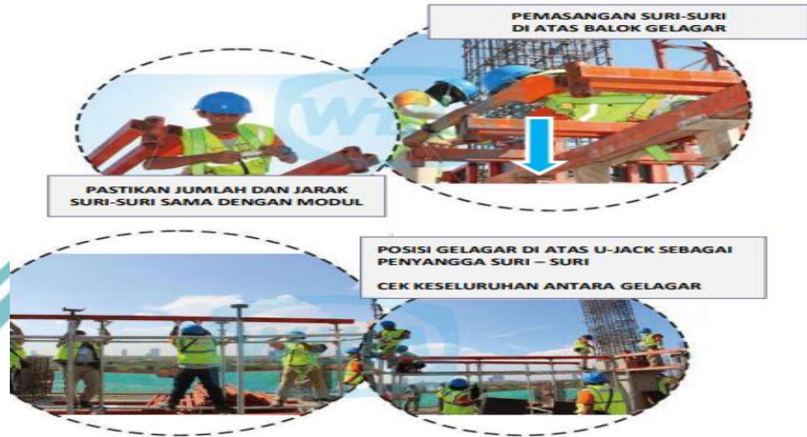
Gambar 3. 96 Ilustrasi Pemasangan Gelagar dan Suri-Suri
