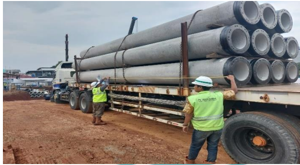
Gambar 3. 60 Spunpile Sumber : Dokumen Pribadi
