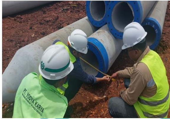
Gambar 3. 29 Checklist Diameter Spunpile Sumber : Dokumen Pribadi
