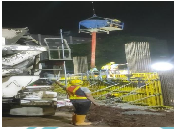
Gambar 3. 93 Pengecoran Retaining Wall Sumber : Dokumen Pribadi
