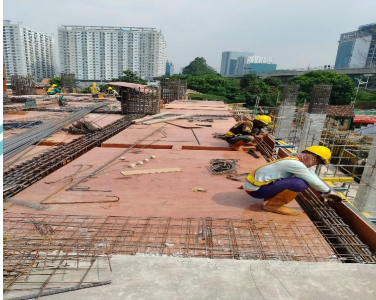
Gambar 3. 100 Pemasangan Multiplek
