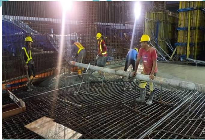
Gambar 3. 102 Pekerjaan Pengecoran Balok dan Pelat Lantai
