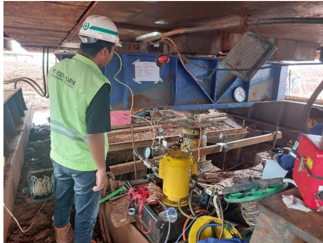
Gambar 3. 75 Pengujian Axial Loading Test Sumber : Dokumen Pribadi
