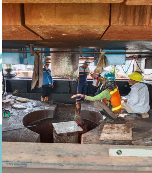
Gambar 3. 78 Pengujian PDA Sumber : Dokumen Pribadi
