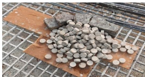
Gambar 3. 63 Beton Decking Sumber : Dokumen Pribadi
