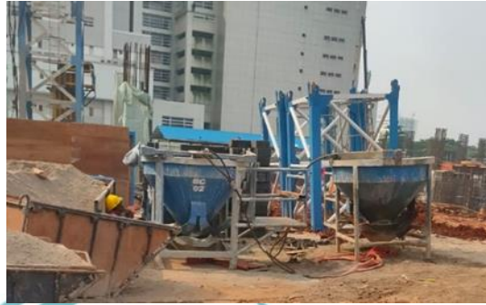
Gambar 3. 46 Concrete Bucket Sumber : Dokumen Pribadi
