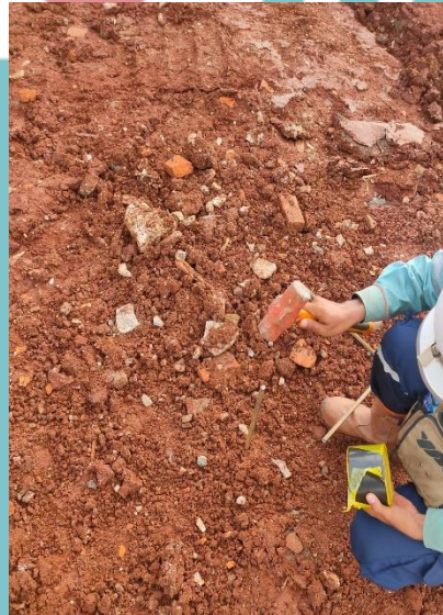
Gambar 3. 72 Penandaan Titik Pancang menggunakan Patok Besi Sumber : Dokumen Pribadi
