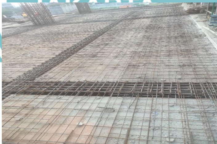
Gambar 3. 101 Pekerjaan Penulangan Balok dan Pelat Lantai
