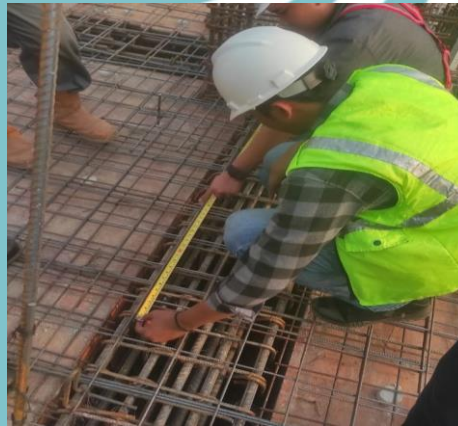
Gambar 3. 25 checklist Penulangan Balok Sumber : Dokumen Pribadi
