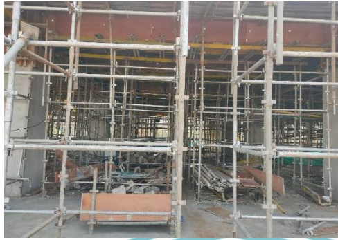
Gambar 3. 54 Scaffolding Sumber : Dokumen Pribadi
