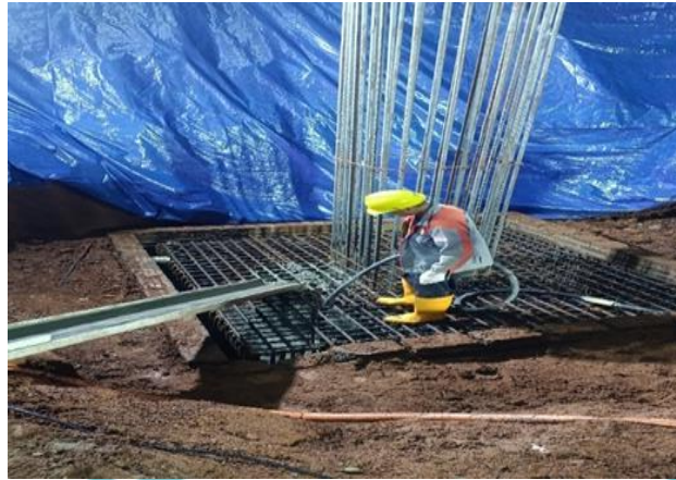
Gambar 3. 83 Pengecoran Pile Cap Sumber : Dokumen Pribadi
