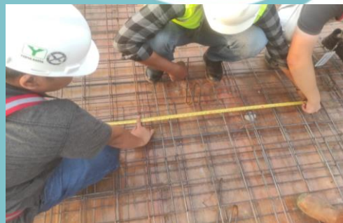
Gambar 3. 27 Checklist Penulangan Pelat Lantai Sumber : Dokumen Pribadi
