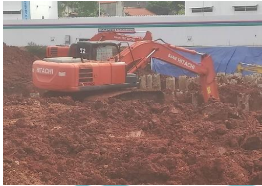
Gambar 3. 37 Excavator Sumber : Dokumen Pribadi
