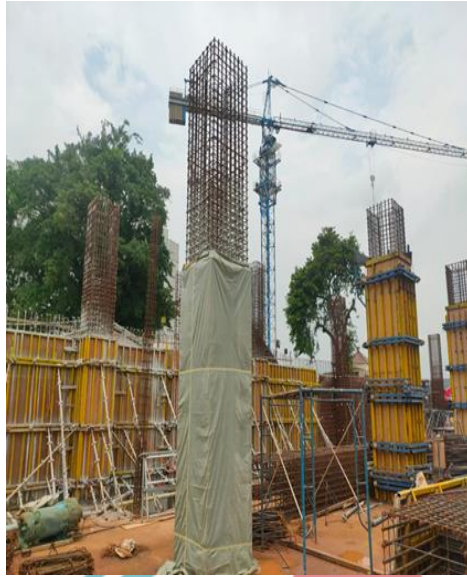
Gambar 3. 90 Curing Beton dengan Plastik Wrap dan Terpal Sumber : Dokumen Pribadi
