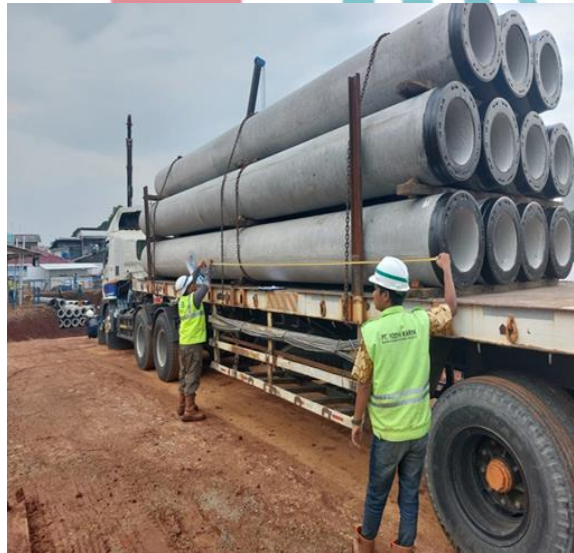
Gambar 3. 30 Checklist Panjang Spunpile Sumber : Dokumen Pribadi
