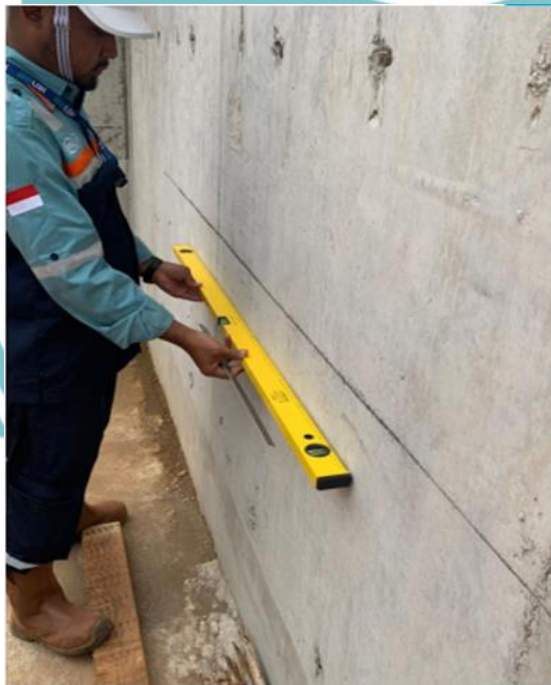
Gambar 3. 111 Pengecekan Kerataan DPT setelah perbaikan Sumber : Dokumen Pribadi
