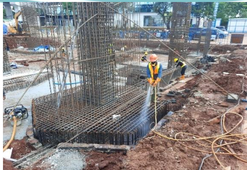
Gambar 3. 81 Penyemprotan Cairan Anti Rayap Sumber : Dokumen Pribadi
