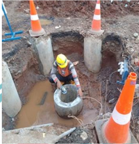
Gambar 3. 79 Pembobokan Kepala Tiang Pancang Sumber : Dokumen Pribadi
