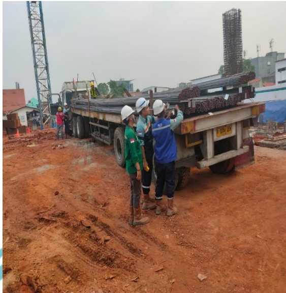
Gambar 3. 31 Checklist Panjang Besi Tulangan Sumber : Dokumen Pribadi
