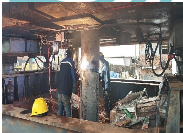
Gambar 3. 74 Pengelasan Joint Sumber : Dokumen Pribadi
