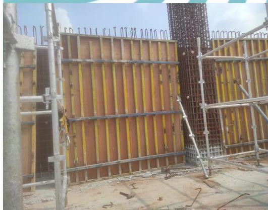
Gambar 3. 92 Pekerjaan Bekisting Retaining Wall Sumber : Dokumen Pribadi
