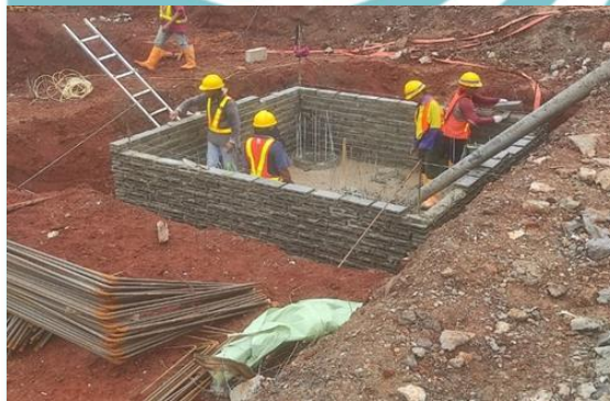
Gambar 3. 80 Pemasangan Bekisting Pile Cap Sumber : Dokumen Pribadi
