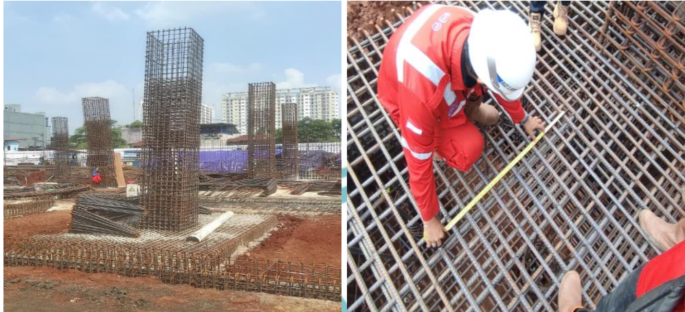
Gambar 3. 19 Checklist Penulangan Pile Cap Sumber : Dokumen Pribadi
