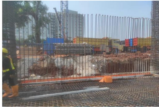
Gambar 3. 91 Pembesian Retaining Wall Sumber : Dokumen Pribadi
