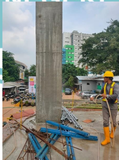
Gambar 3. 89 Curing Beton dengan Menyiram air Sumber : Dokumen Pribadi
