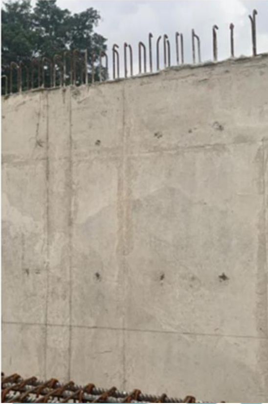
Gambar 3. 110 Hasil Perbaikan DPT Sumber : Dokumen Pribadi
