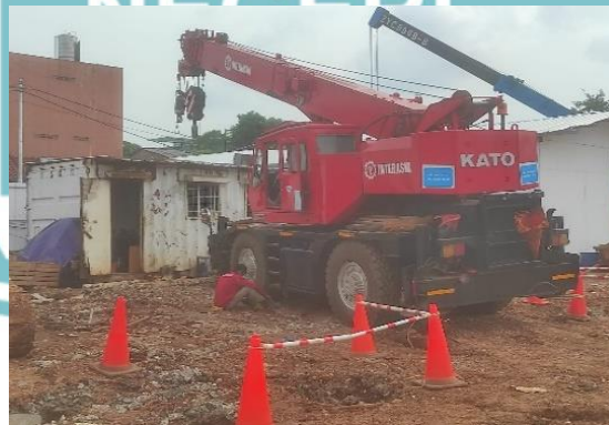
Gambar 3. 43 Mobile Crane Sumber : Dokumen Pribadi
