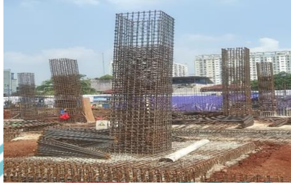
Gambar 3. 86 Pembesian Kolom Sumber : Dokumen Pribadi
