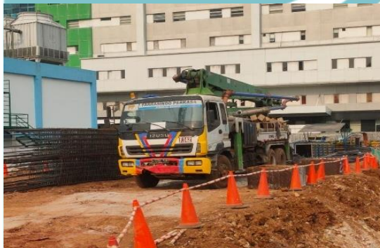
Gambar 3. 47 Concrete Pump Sumber : Dokumen Pribadi
