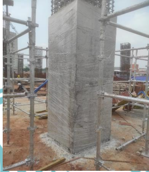
Gambar 3. 90 Curing Beton dengan Plastik Wrap dan Terpal Sumber : Dokumen Pribadi
