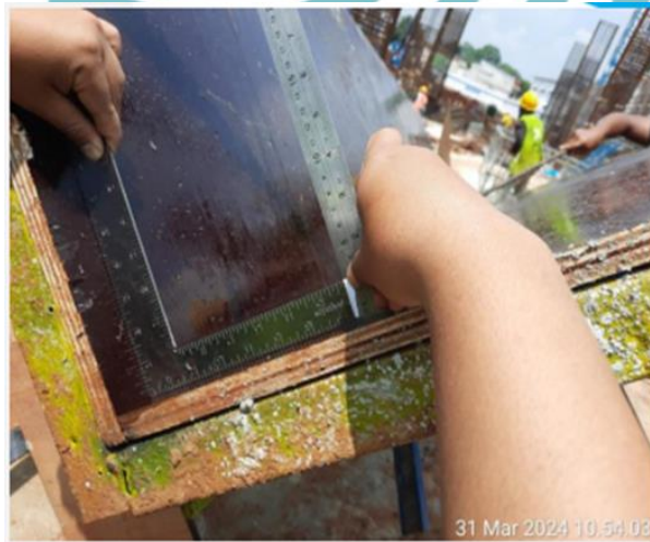
Gambar 3. 107 Pekerjaan Perbaikan Kolom Tidak Siku
