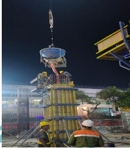
Gambar 3. 88 Pengecoran Kolom Sumber : Dokumen Pribadi
