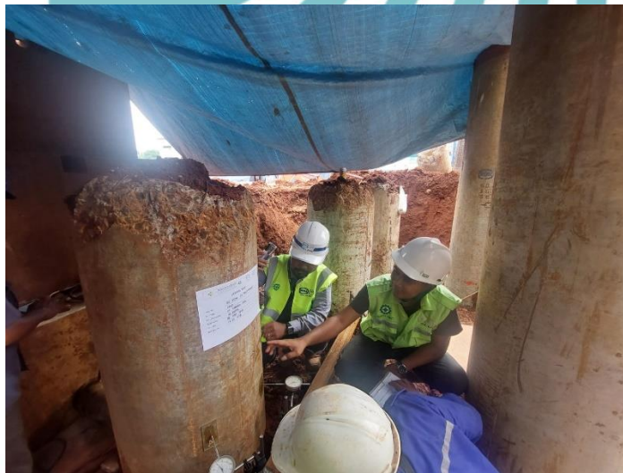
Gambar 3. 76 Pengujian Axial Tensile Loading Test Sumber : Dokumen Pribadi
