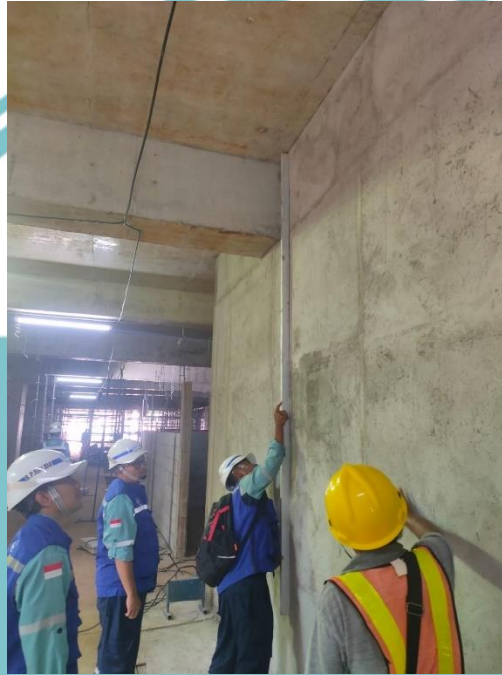
Gambar 3. 36 QPASS Pekerjaan Dinding Sumber : Dokumen Pribadi
