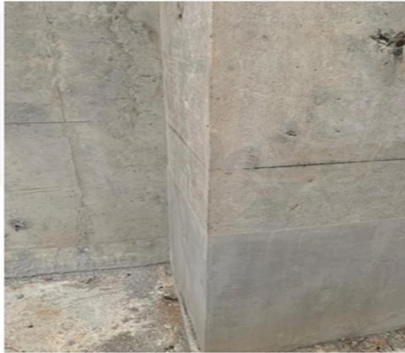
Gambar 3. 108 Hasil Pekerjaan Perbaikan Kolom Sumber : Dokumen Pribadi
