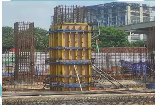
Gambar 3. 87 Pekerjaan Bekisting Kolom Sumber : Dokumen Pribadi
