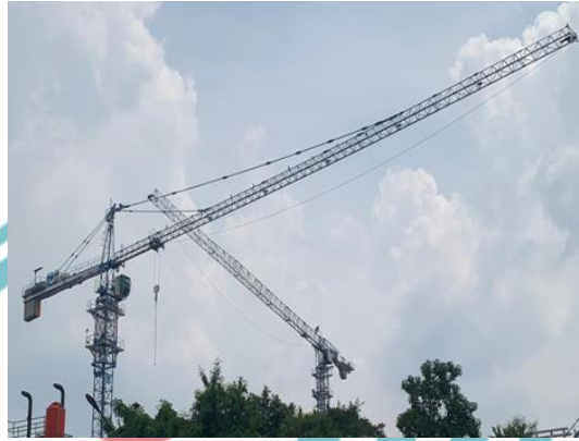
Gambar 3. 42 Tower Crane Sumber : Dokumen Pribadi
