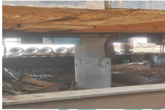
Gambar 3. 73 Pemancangan Sumber : Dokumen Pribadi
