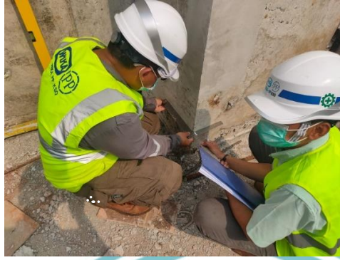
Gambar 3. 33 QPASS Pekerjaan Kolom Sumber : Dokumen Pribadi
