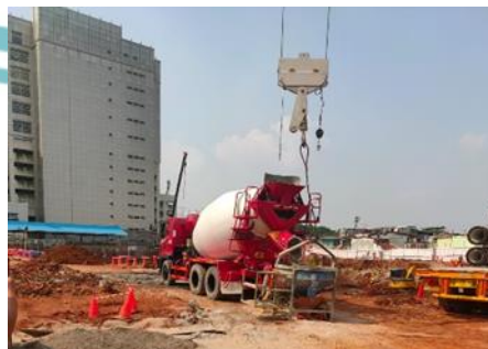
Gambar 3. 61 Beton Ready Mix Sumber : Dokumen Pribadi
