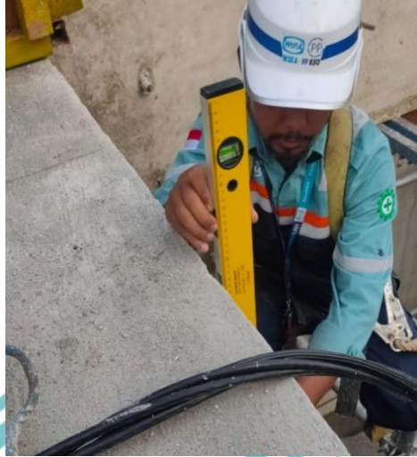
Gambar 3. 34 QPASS Pekerjaan Balok Sumber : Dokumen Pribadi
