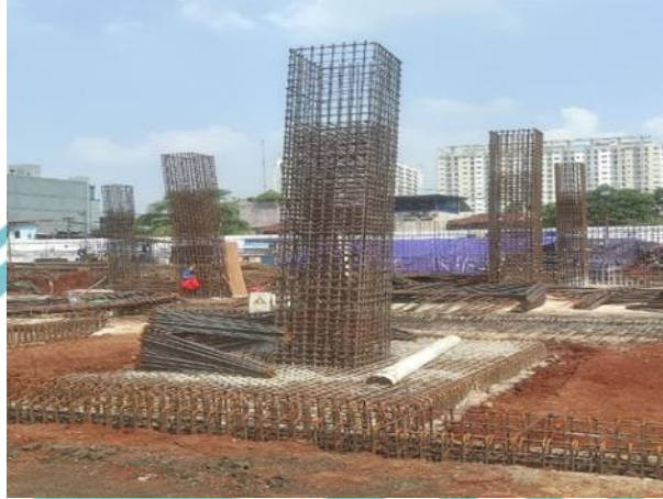
Gambar 3. 82 Penulangan Pile Cap Sumber : Dokumen Pribadi
