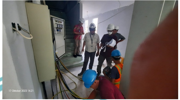
Inspeksi tahanan isolasi instalasi electrical yang terpasang bersama pihak kontraktor (Sumber : Dokumentasi Pribadi)
