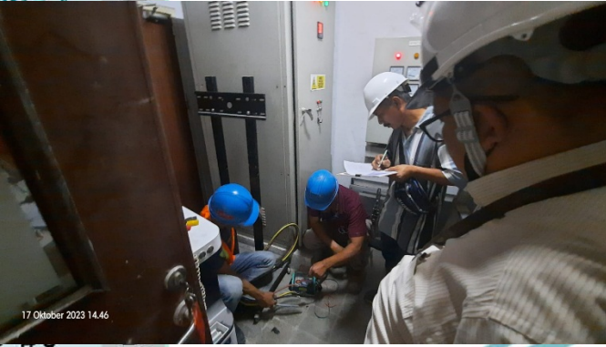
Inspeksi tahanan isolasi instalasi electrical yang terpasang bersama pihak kontraktor (Sumber : Dokumentasi Pribadi)
