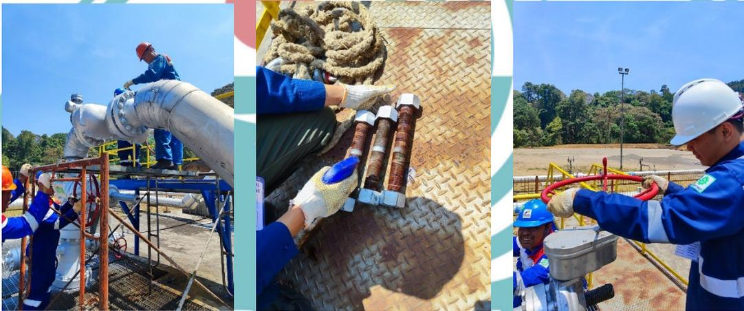
**11. Overhaul Hot Well Pump Unit 4, Pembongkaran dan Instalasi Shaft**
