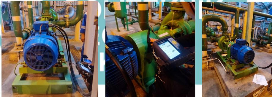
**22. Maintenance chemical dosing pump (NaOH), pembersihan screen pada separator chemical dosing pump**
