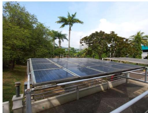
Gambar 3. *Shading* pada modul surya
